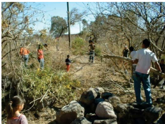
Inicio de los trabajos.
